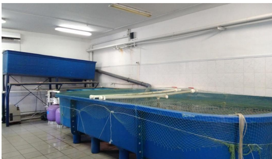
Рисунок 1 - Установка замкнутого водоснабжения НИИ ЗКАТУ им. Жангир хана
