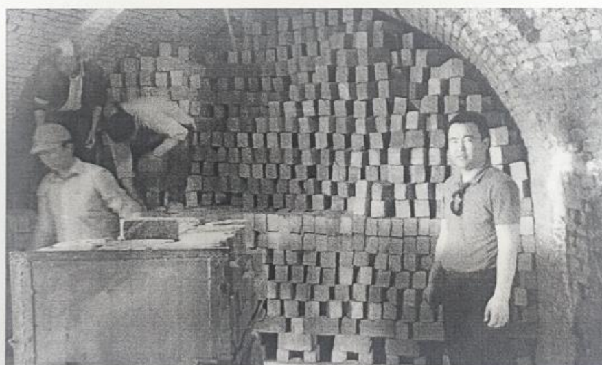
Рис 6. Процесс садки кирпича-сырца с использованием энергосодержащего компонента в виде конгломератной смеси на основе нефтешлама в заводскую кольцевую печь.
